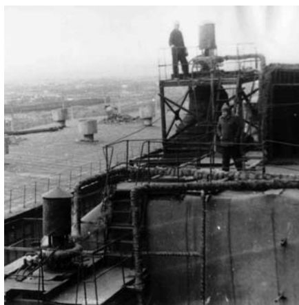
Рис. 5. Акустическое осаждение промышленных дымов а – Новочеркасская ГРЭС; б – Лакокрасочный завод
